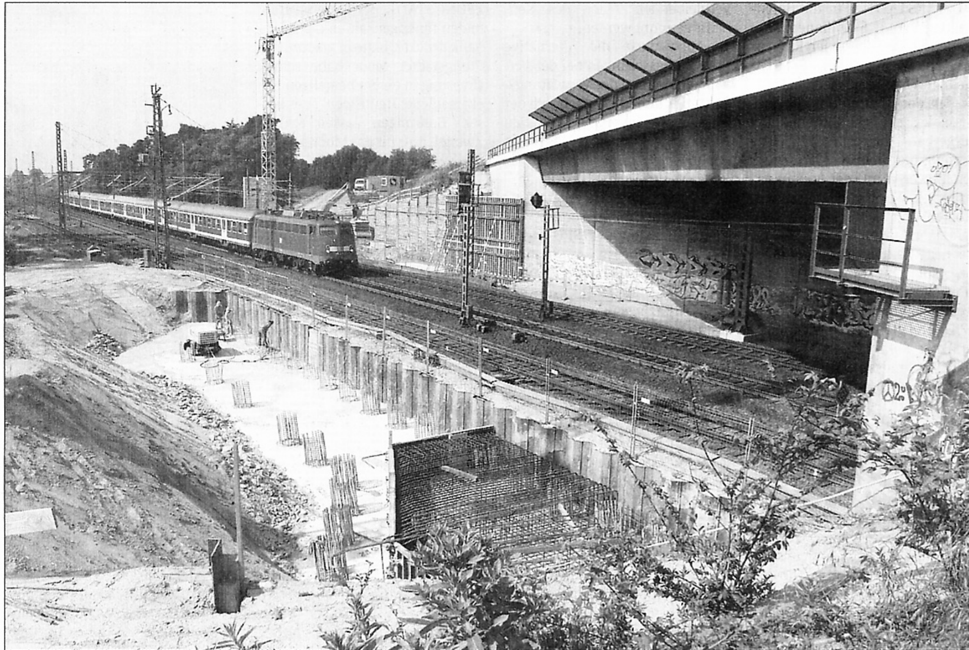
Ende Dezember soll Bickenbachs Nordumgehung fertig sein. Seit Mitte März wird an der Brücke über die Bahngleise gearbeitet. FOTO: ERNST SELINGER
