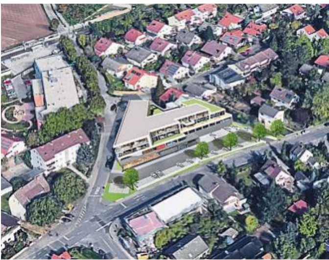
Direkt an der Alten Bergstraße (unten) entsteht der rund zehn Millionen Euro teure Rewe-Komplex.
